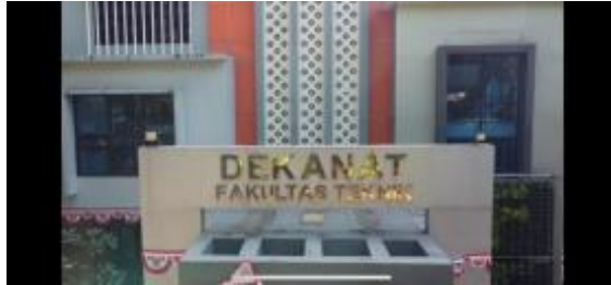
Gambar 3. Gedung Dekanat Sumber : Dokumentasi penulis, 2025
